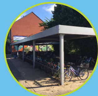
Instandsetzung des Fahrradständers
